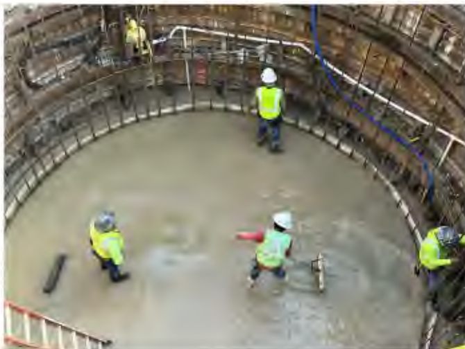
Wet Well Concrete Pour
