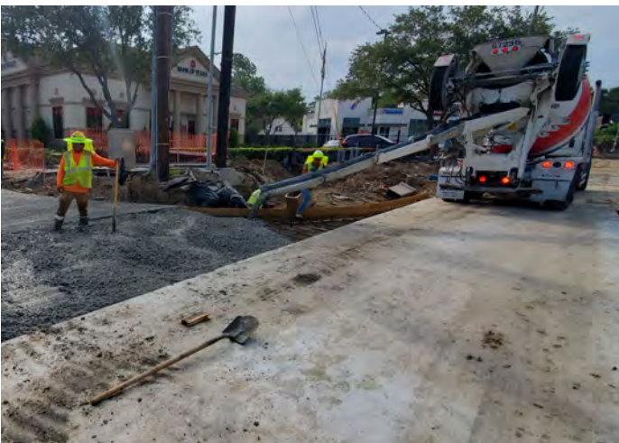
Driveway Concrete Pour
