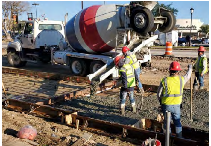
Concrete pour in progress
