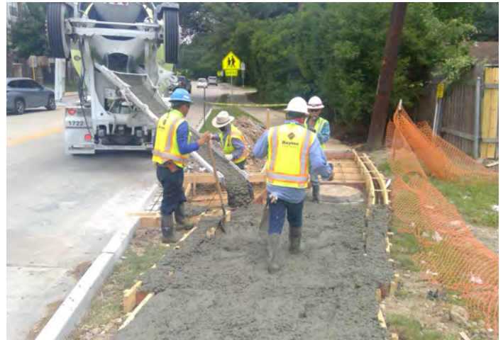
Concrete Pour for sidewalk - Bunker Hill Rd
