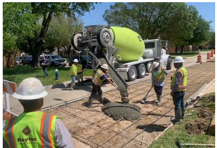
Concrete Pour - Long Branch
