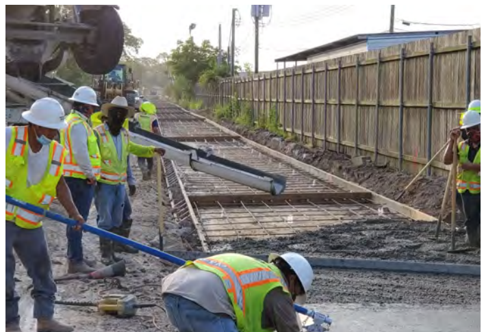
Concrete Pour work continues.
