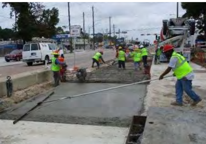
Concrete Pour on Northbound Lane 2.
