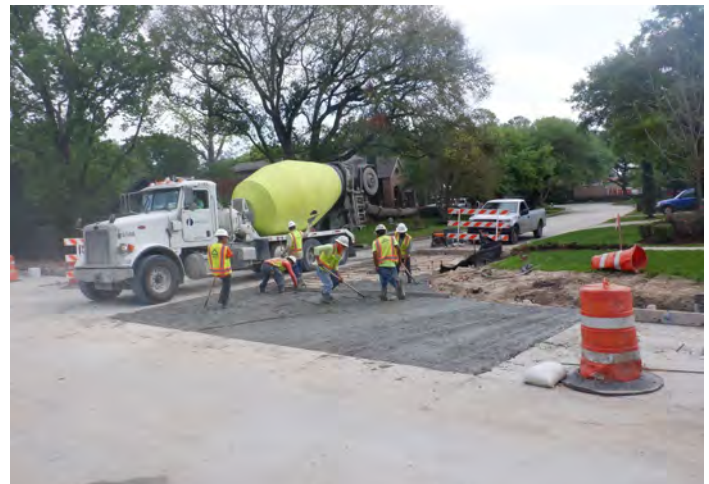
Concrete pour on Windhover lane
