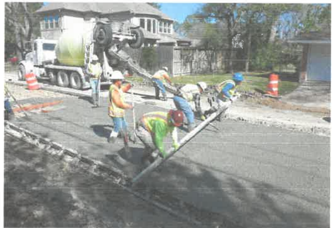
Pouring paving straw 4.
