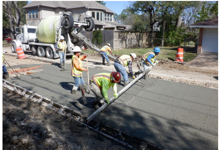
Pouring paving straw 4.
